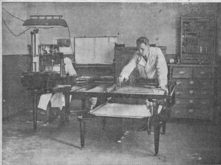
Обр. 6. — Картране въ Географския институтъ отъ фотограмметрични снимки съ автографа Вилдъ. — Au travail, avec l'autographe Wild dans l'Institut Géographique militaire bulgare.
