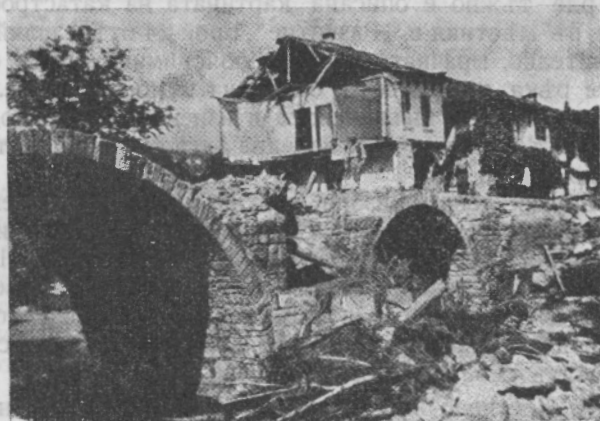
Фиг. 5 — Повреденъ камененъ мостъ въ с. Стокитъ Un pont de pierre endommagé par la crue des eaux.
