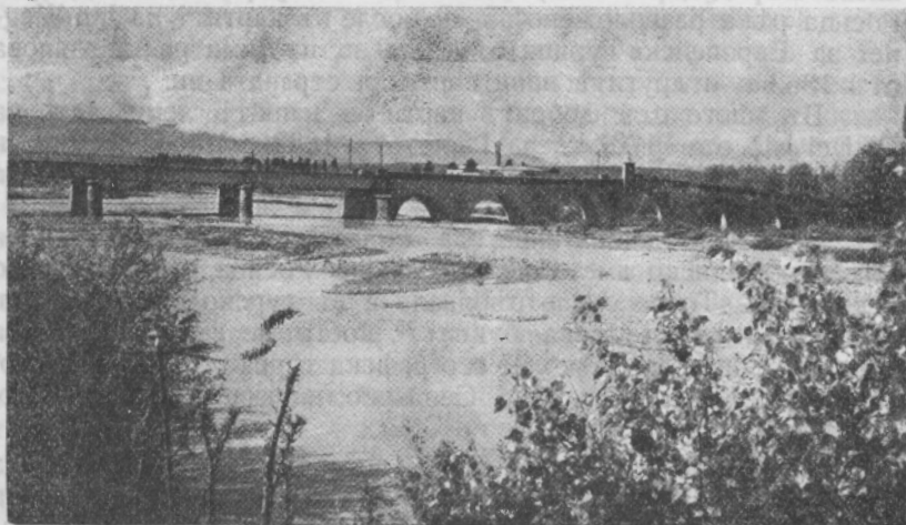
Фиг. 1. — Стариятъ турски мостъ на Росица при Севлиево fig. 1: — L'ancien pont sur la rivière Rossitza à Sevlievo.
